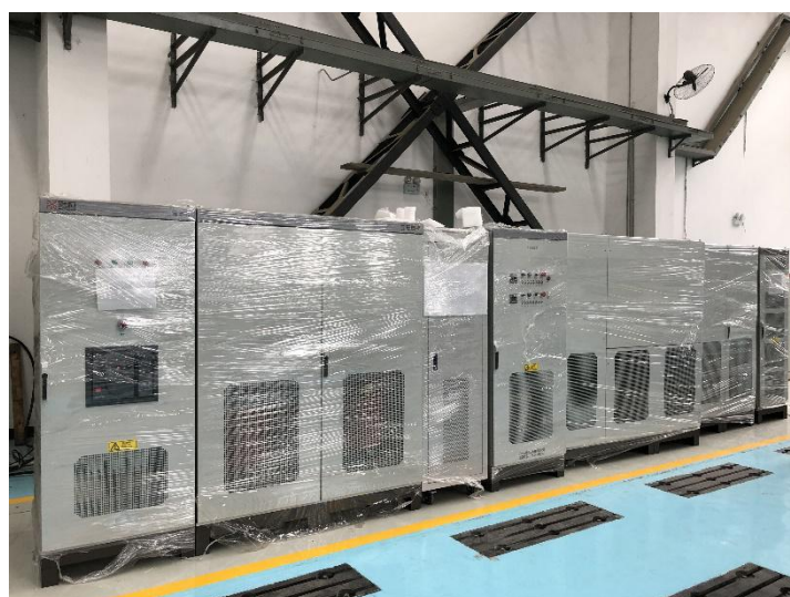
(b) 200kW 非接触牵引供电电源
